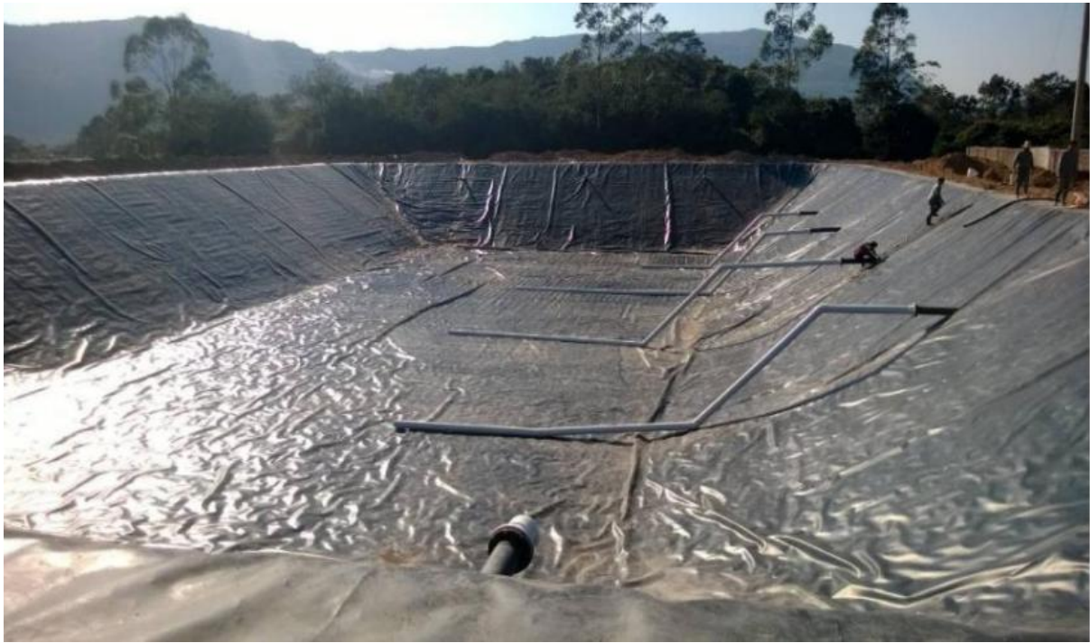
图3-2-3 黑膜沼气池内部示意图（仅供参考，非本项目）
